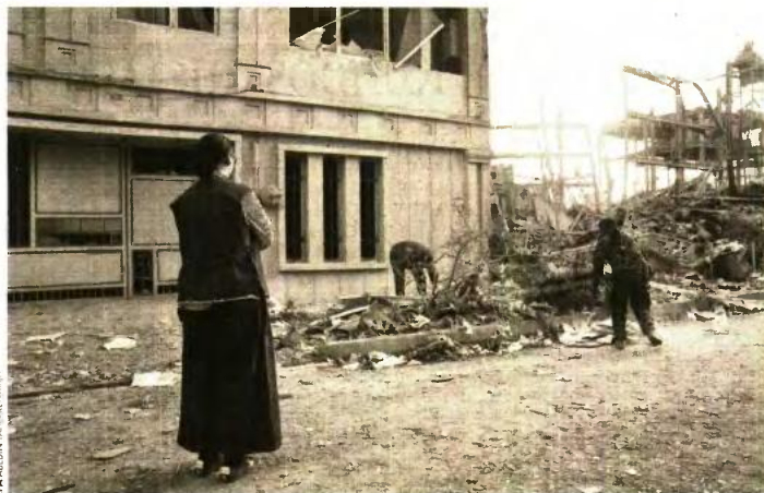
► Ιρανοί εξετάζουν κατεστραμμένα από τους βομβαρδισμούς κτίρια σε κατοικημένη περιοχή στο κέντρο της Τεχεράνης
