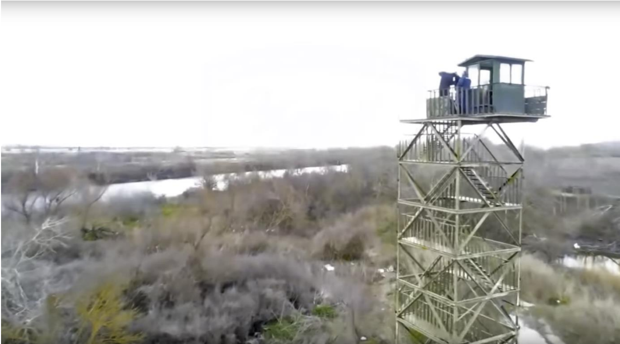
Εικόνα 6: Πύργος Επίγειας Επιτήρησης των ελληνοτουρκικών συνόρων (Πηγή ΓΕΕΘΑ).
